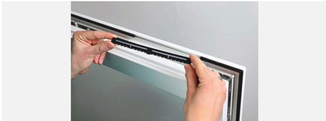
Der Fensterfalzlüfter Arimeo Classic S wird in die Dichtungsebene eingeklippt. Foto: Innoperform
